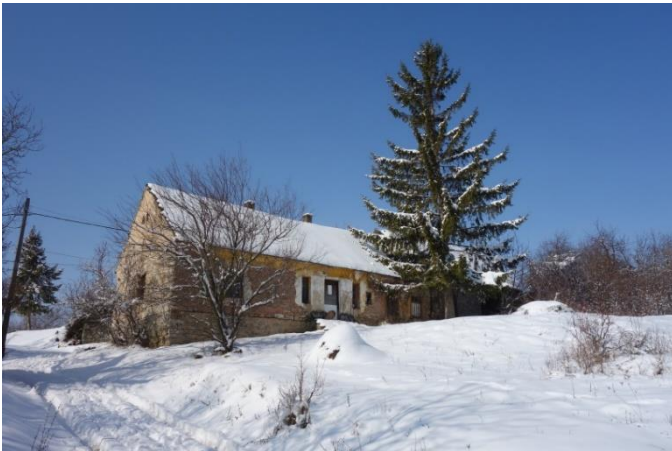
Lakóház Fő utca 26. hrsz.: 45
