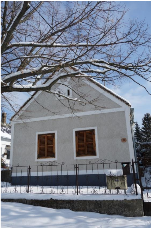
Lakóház Fő utca 18. hrsz.: 27
