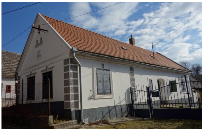
Lakóház Fő utca 34. hrsz: 54
