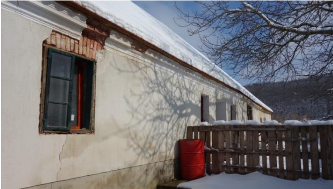
Lakóház Fő utca 24. hrsz.: 40
