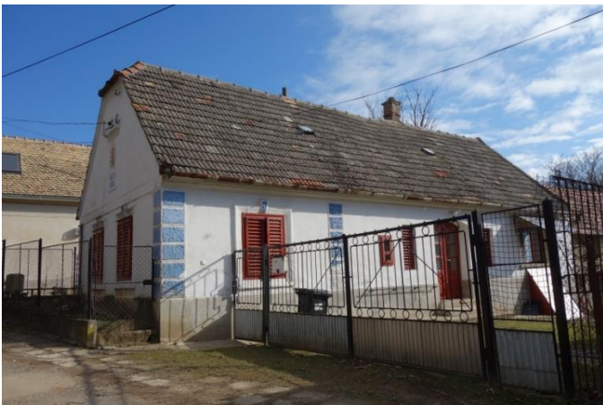
Lakóház Fő utca 33. hrsz.: 53
