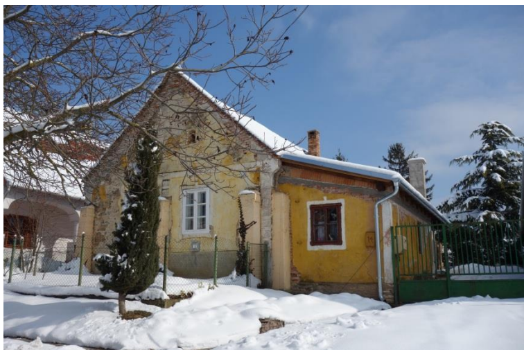
Lakóház Fő utca 14. hrsz.: 21
