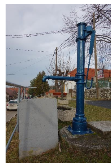
Felújított vert kút Döbrente
