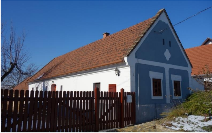
Lakóház Fő utca 64. hrsz.: 87
