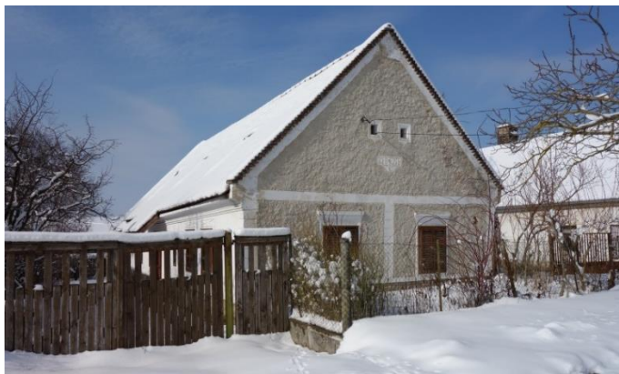
Lakóház Fő utca 55. hrsz: 78
