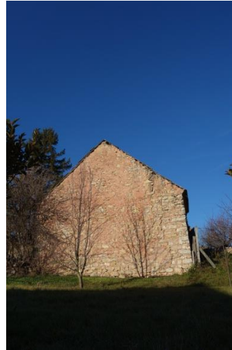
Lakóház Fő utca 15. hrsz.: 22
