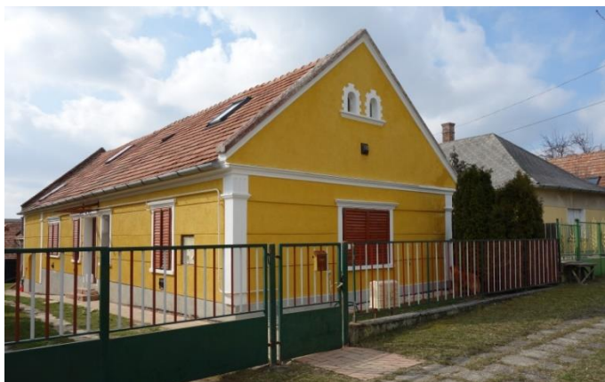
Lakóház Fő utca 53. hrsz.: 76
